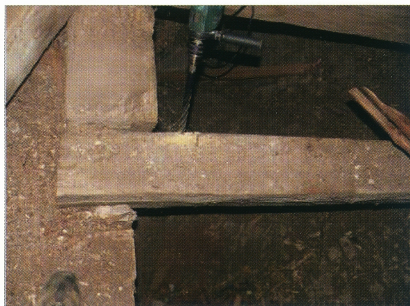
2 pav. Perdangos balkis virš presbiterijos, datuotas 1572 m. Nuotraukoje matyti medienos mėginių paėmimo grąžtas.
