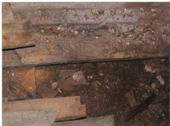
1 pav. Perdangos balkis virš presbiterijos. Kairėje pusėje matyti gręžinio paėmimo vieta ir už jos esanti sandūra su kitu perdangos balkiu.
