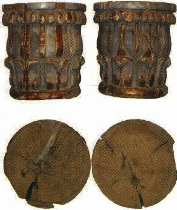
6 pav. Išardyto altoriaus kolonų elementai iš liepos medienos. Skersiniame pjūvyje, trečios nuotraukos apačioje, ketvirtosios nuotraukos viršuje, dešinėje, matyti priklijuoti pušies medienos intarpai.
