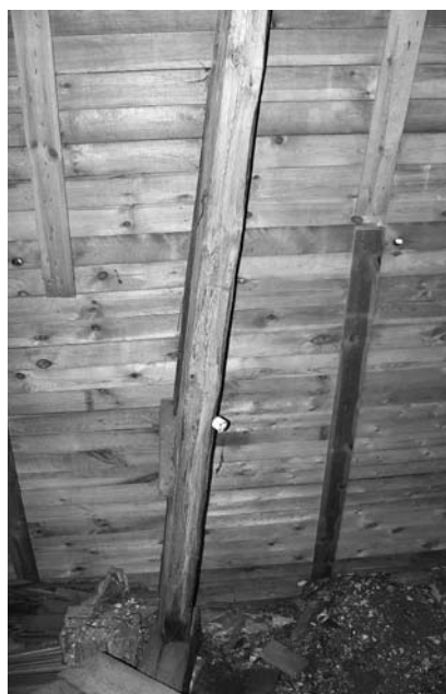
4 iliustracija. Gegnė presbiterijos dalyje. Mediena kiršta 1676 m. Adomo Vito nuotrauka, 2018
