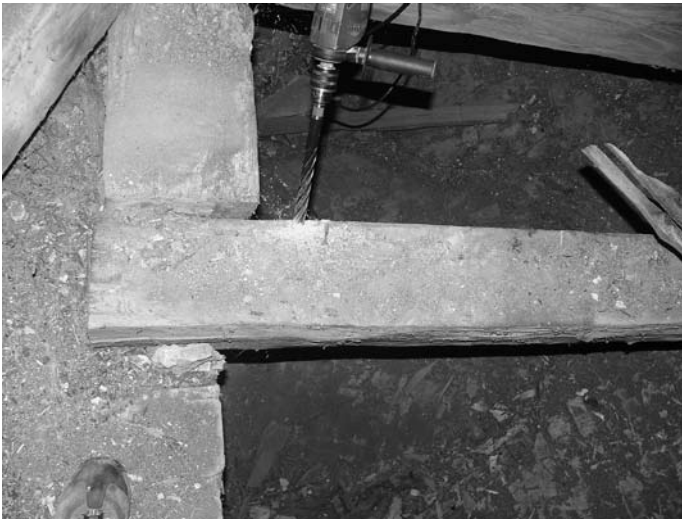
2 iliustracija. Perdangos sija virš presbiterijos, datuota 1572 m. Nuotraukoje matyti medienos mėginių paėmimo grąžtas. Adomo Vito nuotrauka, 2018
